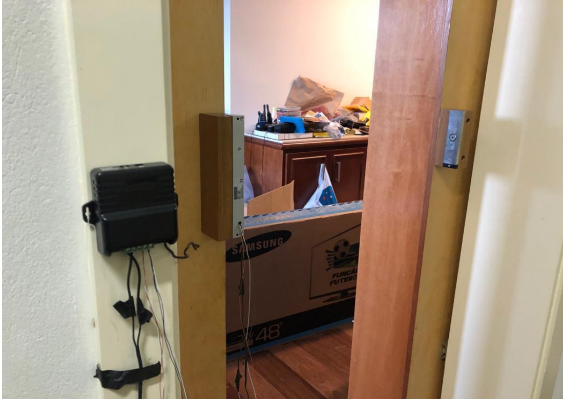
Foto 1: Entrada do “Quarto de Pânico”, com destaque ao dispositivo eletrônico instalado, que possibilitava a entrada no local mediante acionamento de controle remoto.
