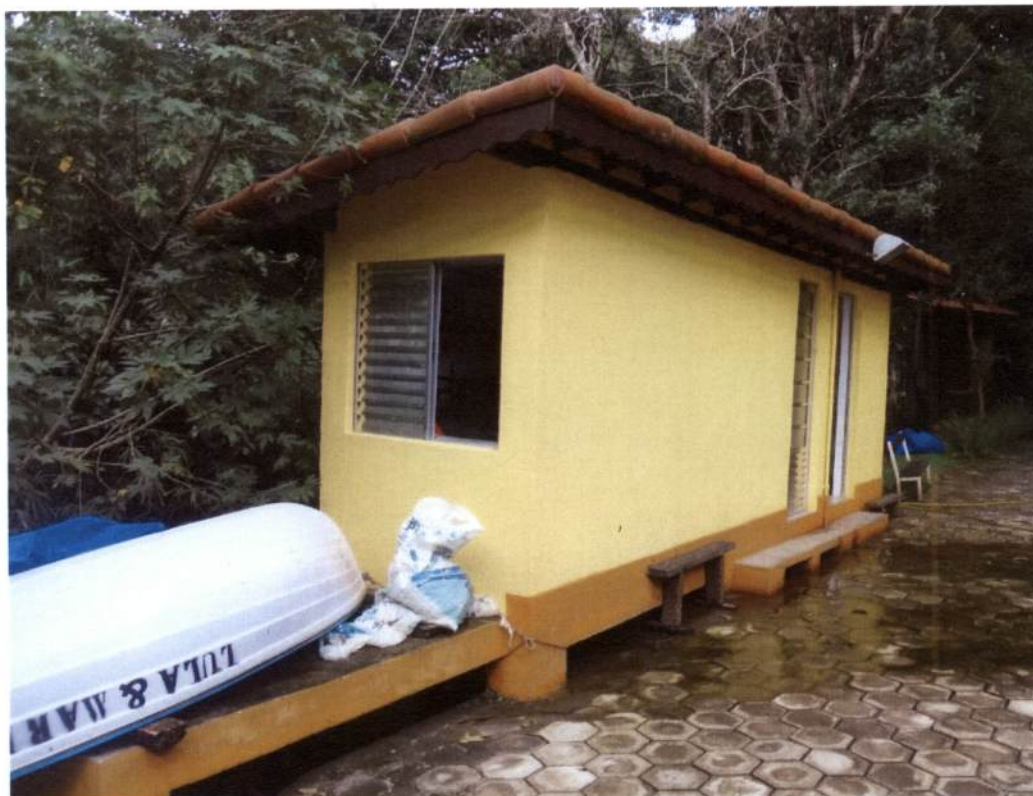
Figura 33 – Vista geral da Casa de Barco.
