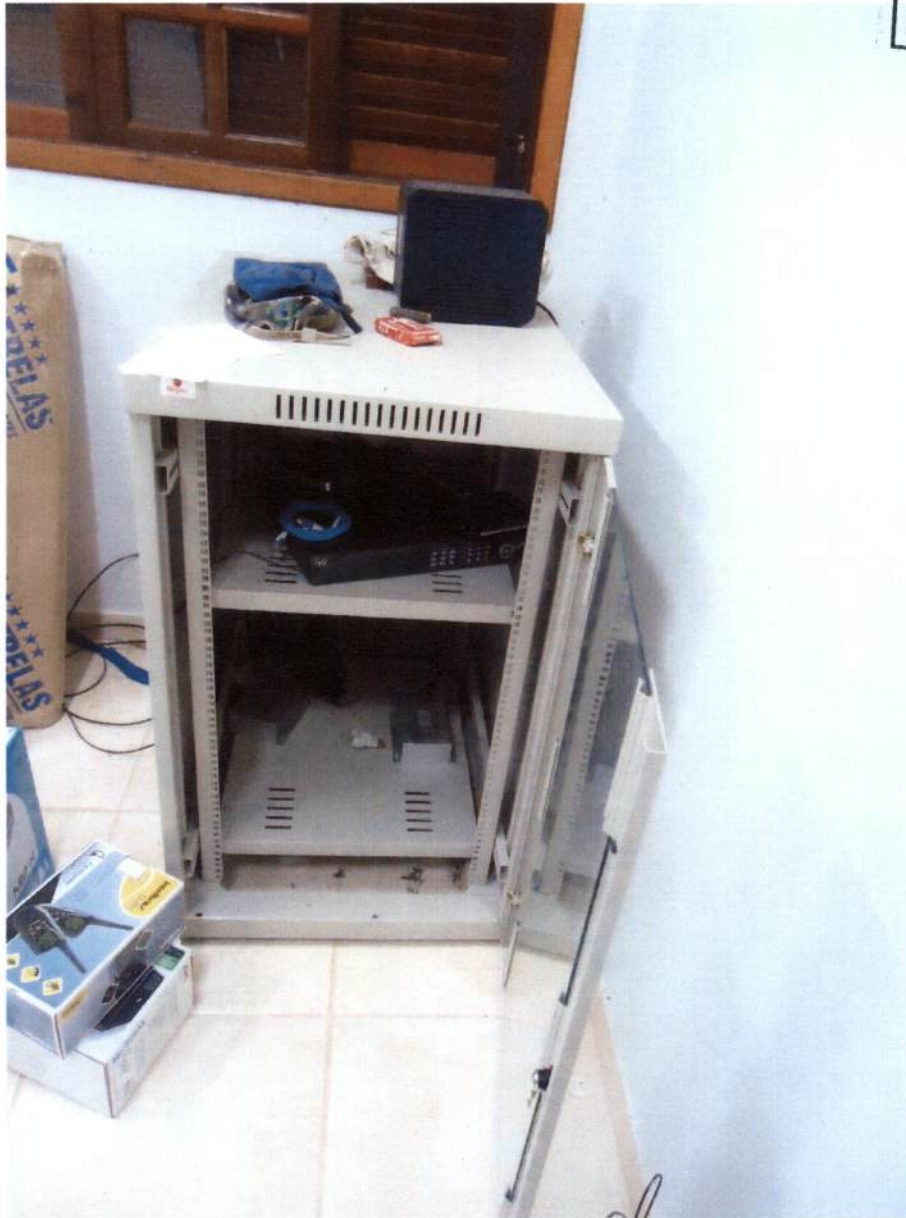
Figura 65 - Vista interna de um dormitório com destaque para o armário e os equipamentos de monitoramento.
