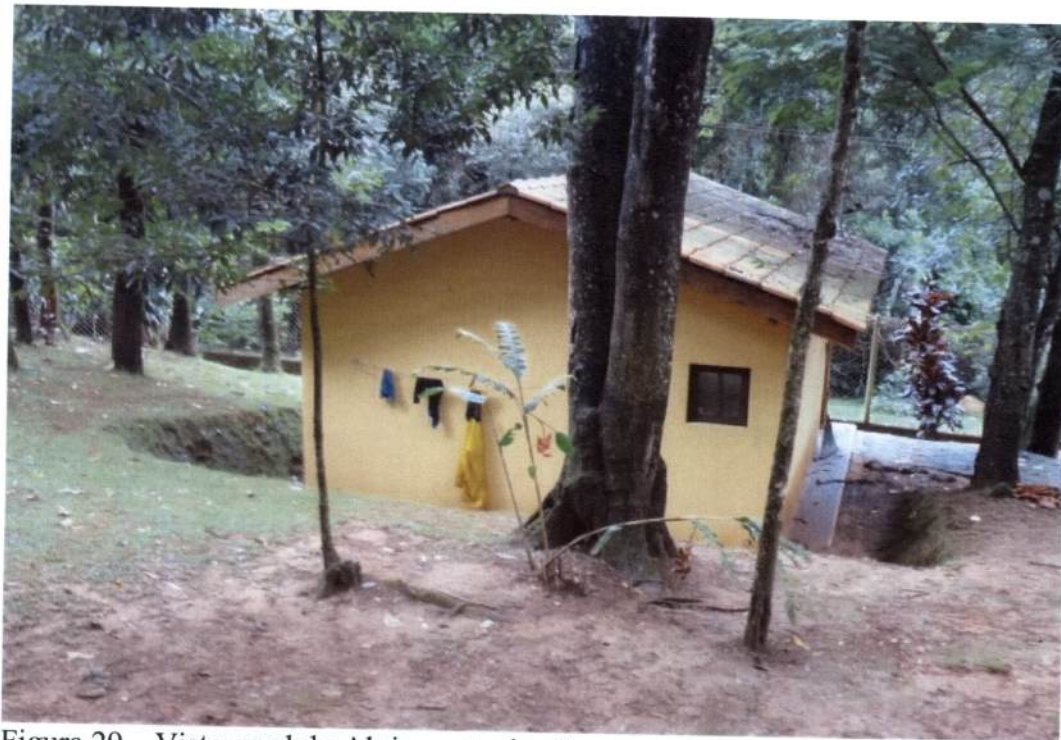
Figura 29 – Vista geral do Alojamento dos Seguranças.
