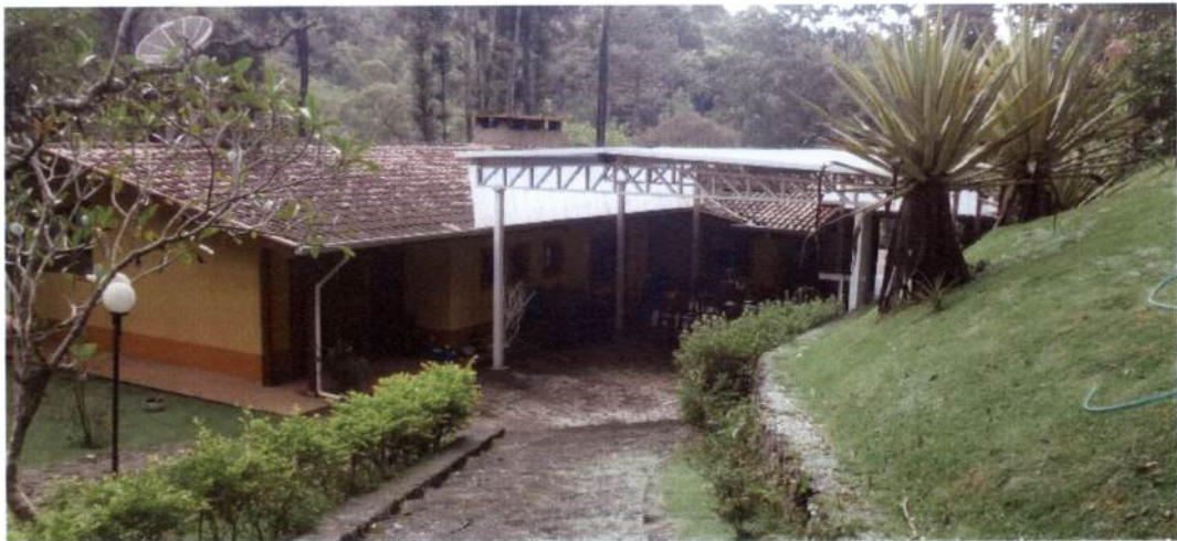
Figura 6 – Vista dos fundos da Casa Principal.
