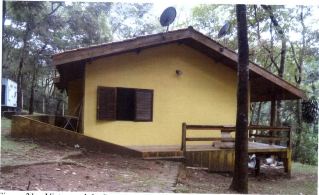
Figura 31 – Vista geral da Casa do Caseiro
